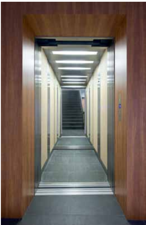
Ansicht Aufzugsanlage Obergeschoss
